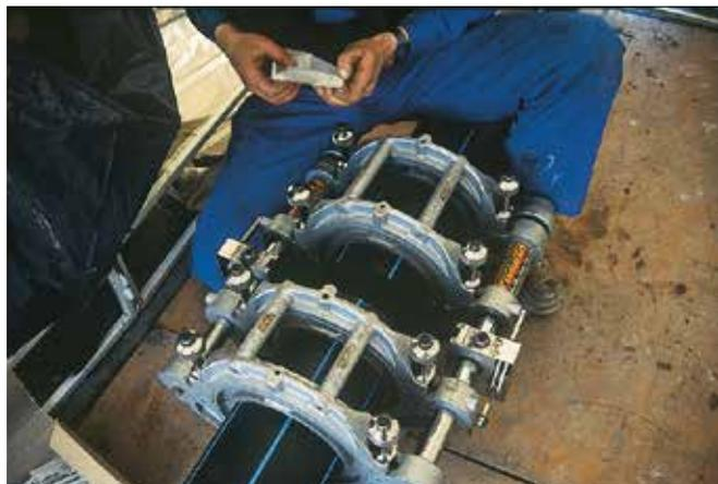
Il est en effet impératif de procéder au nettoyage intérieur et extérieur du tube avant le soudage à l'aide d'un solvant dégraissant adapté ou des lingettes pré-imprégnées.
