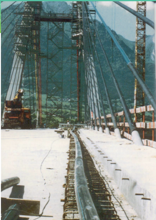
Mise en œuvre d'une canalisation AEP sur un pont.
