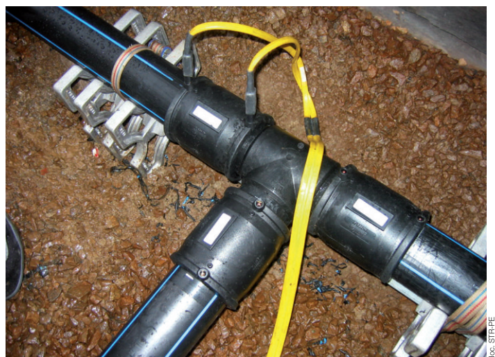
Cet assemblage par électrosoudage garantit une étanchéité optimale des canalisations en PE.
