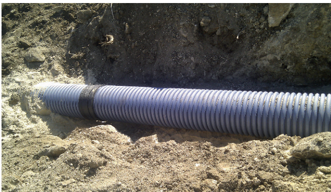
Les tubes annelés en PE offrent des solutions durables et performantes pour l'assainissement.
