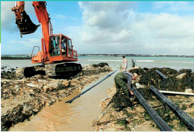
Pose en immergée des canalisations en PE.
