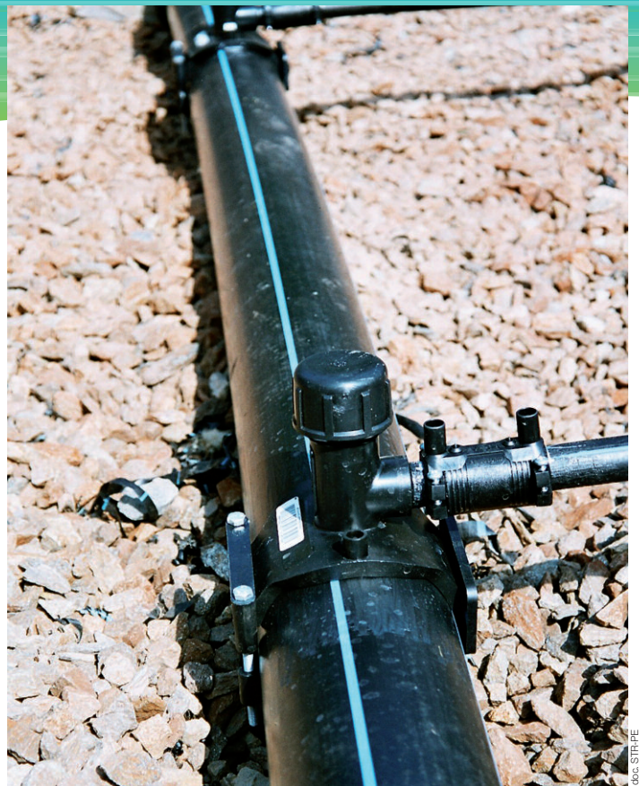
Illustration d'une prise de branchement en PE.
