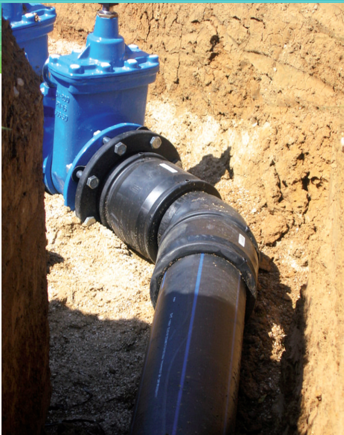
Les raccords par soudage contribuent à la réduction considérable des déperditions en eau dans les canalisations.
