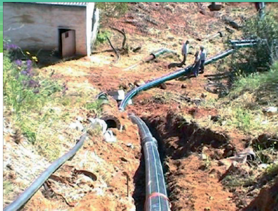
Exemple de pose de canalisation AEP en terrain accidenté.
