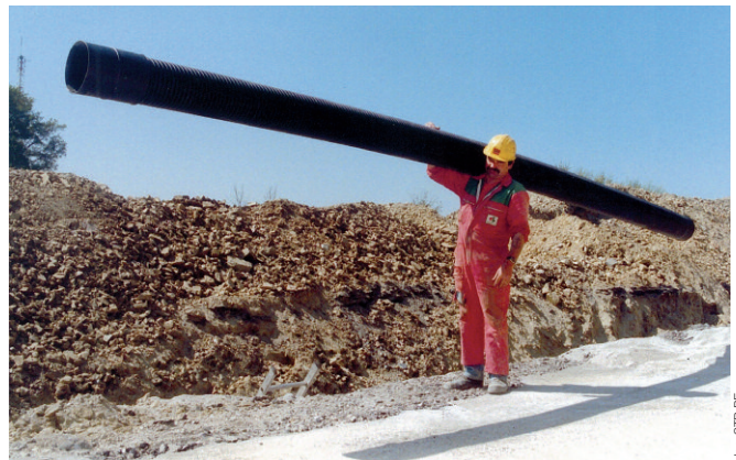
Véritable confort pour les professionnels, la légèreté des tubes annelés en PE et en PP garantit la compétitivité des chantiers.
